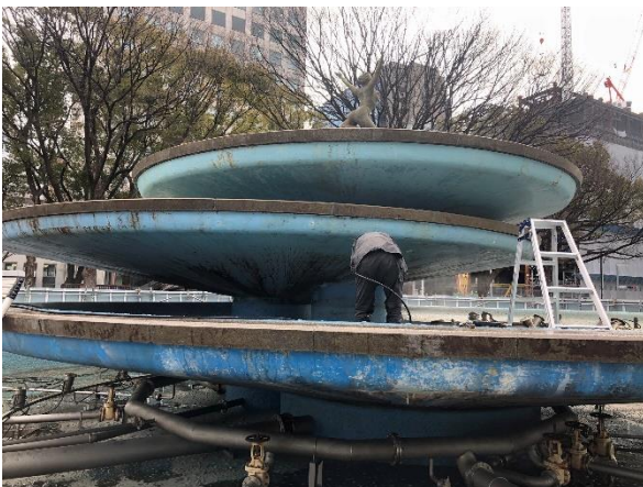
希望の泉 修繕工事中 (2022年2月)
