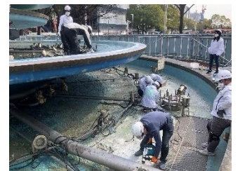
修繕工事の様子
