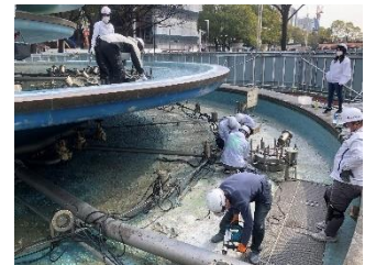
修繕工事の様子
